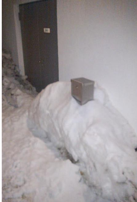
So sah der Zugang zu einer Brandmeldeanlage und einem Feuerweherschlüsseldepot aus: 80 cm Neuschnee erschwerten den Zugang deutlich. Auch hier ist seitens der Betreiber und Eigentümer mit einem funktionierenden Winterdienst dafür zu sorgen, dass Lösch- und/oder Rettungsarbeiten nicht unnötig verzögert werden.
